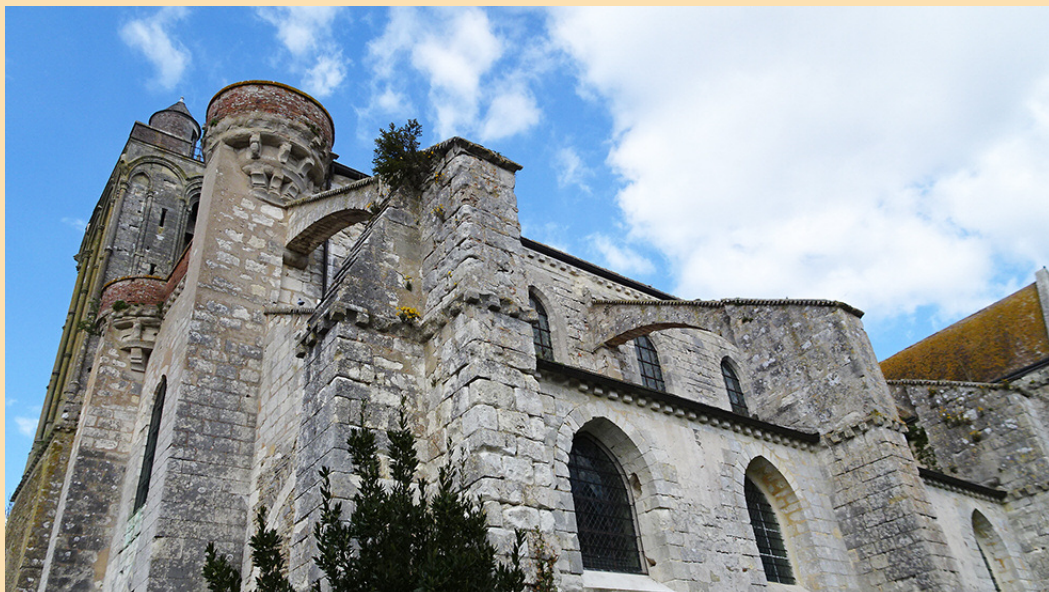
Le côté sud de la nef
