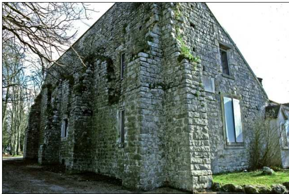
Franchard , murs ouest et sud de la chapelle de l'Ermitage.
